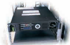
Auf manuellen Bypass umschalten, S1 oder S2.
